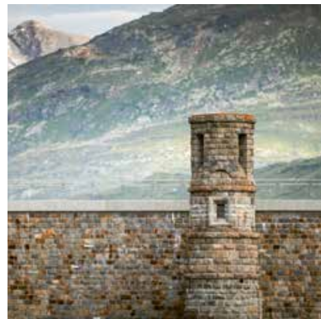
Der Lago Bianco – hier die südliche Staumauer – bildet einen wichtigen Bestandteil der Wasserkraftwerke im Puschlav.
