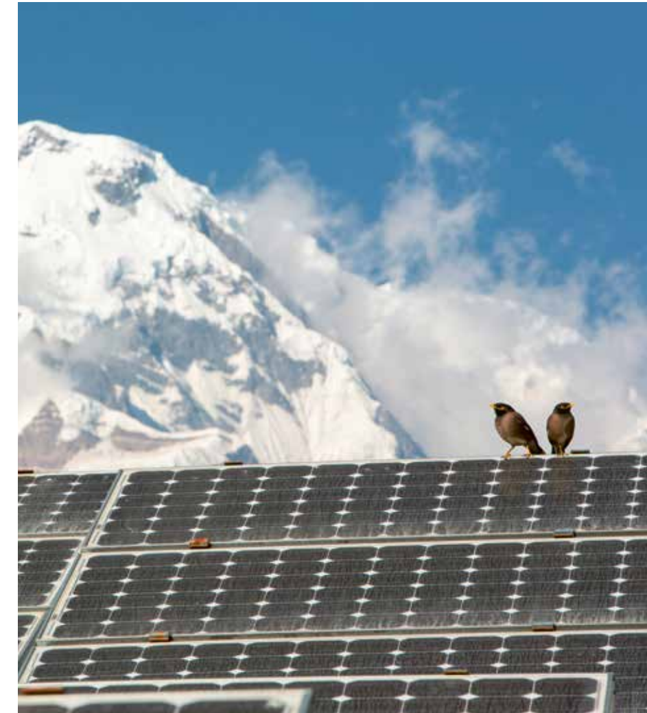
Mehr solarer Winterstrom im Gebirge: Es hat weniger Nebel, und die Reflexion des Sonnenlichts auf dem Schnee erhöht den Ertrag. Zudem steigert die Kälte den Wirkungsgrad.
