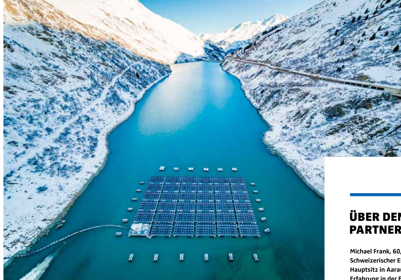
Schwimmende Solaranlage auf dem Stausee Lac des Toules im Wallis: Die Pilotanlage liefert seit 2019 Strom für 220 Haushalte.
